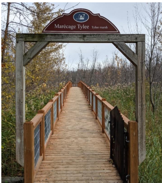
Figure 29. Passerelle du marécage Tylee, restaurée en 2021 (photo A. St-Denis).
